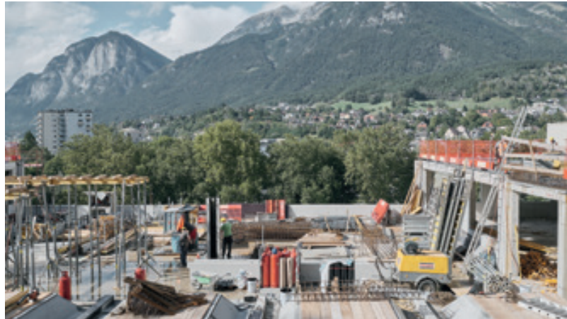
Universität Innsbruck Baustelle Multifunktionsgebäude Architektur: Mohr Architekten Foto: David Schreyer
